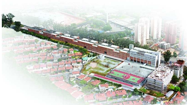
a) Campus Vila Yara: vista aérea
